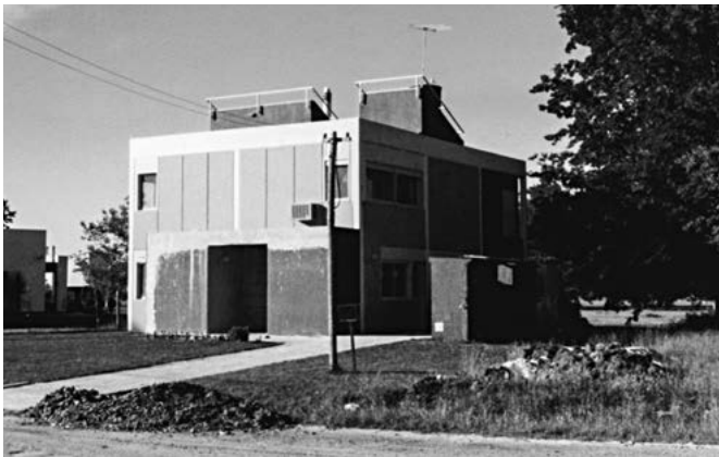
Mi casa en el country SHA durante su construcción en estilo Le Corbusier, 1977.
